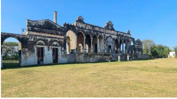
El estado actual de la construcción es lamentable.
