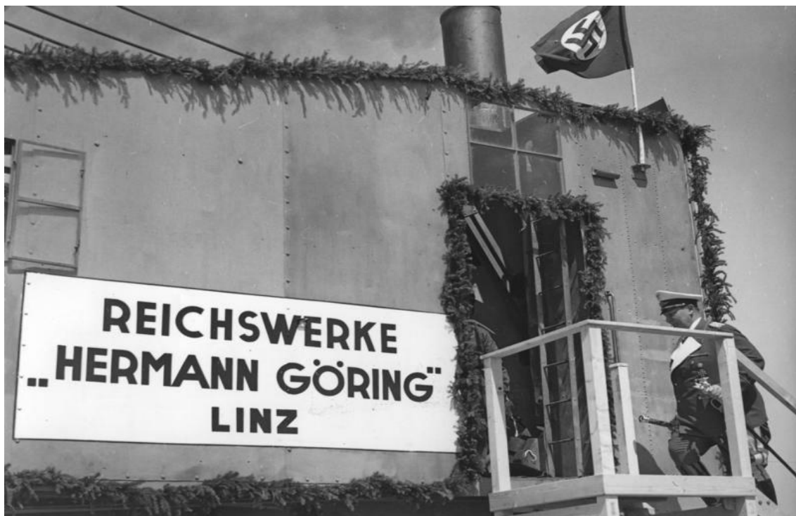
Hermann Göring visitando la construcción del Reichswerke, sede Linz, 13 de mayo de 1938.
